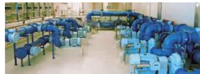
ОБОГРЕВ ПОЛОВ НАСОСНЫХ СТАНЦИЙ
